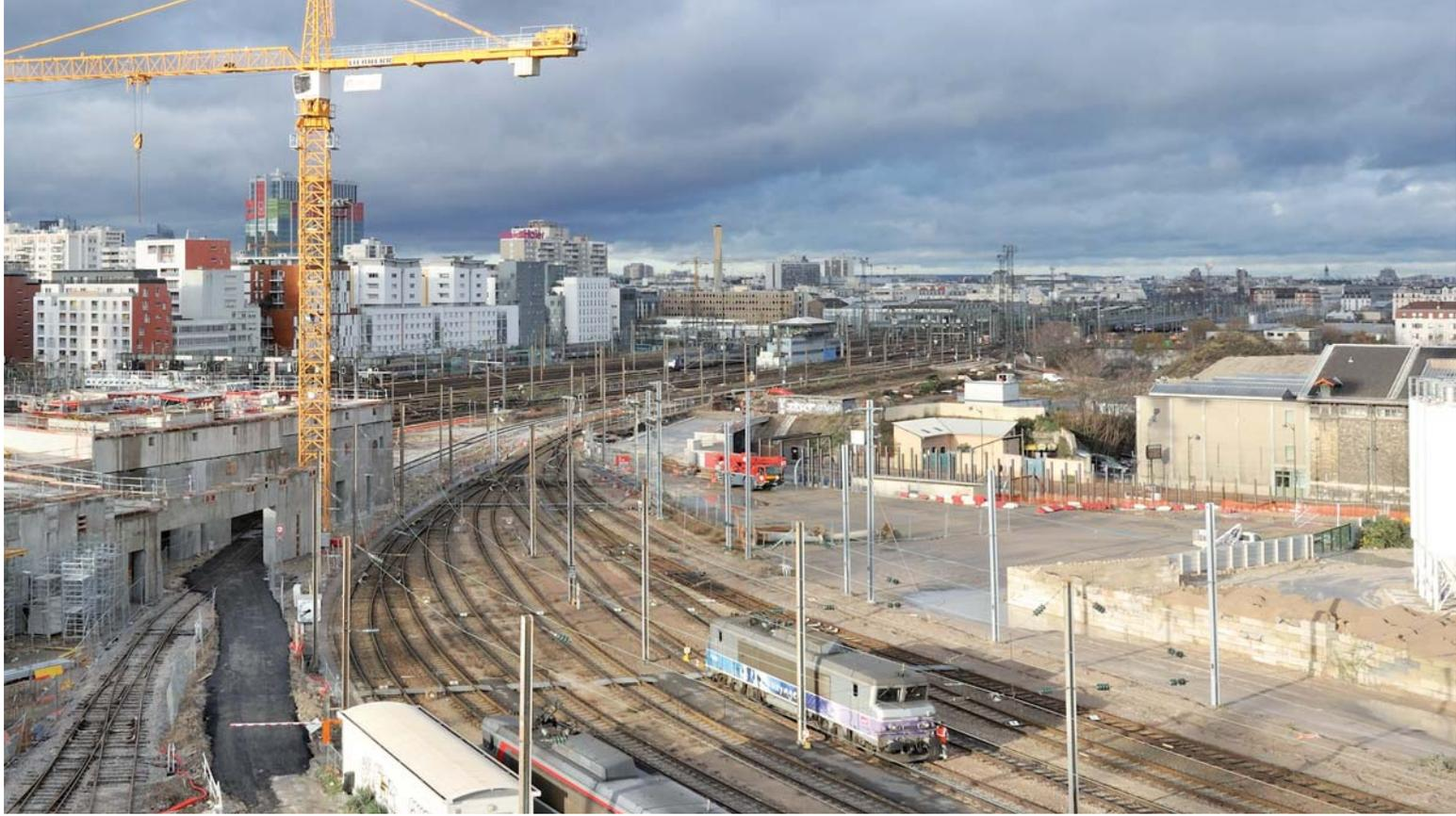
découpant la dalle Nord en trois morceaux structurellement indépendants. Longitudinalement, un joint de dilatation sépare certaines parties de la couverture positionnées sur appareils d'appuis à pot des parties qui viennent s'en-
