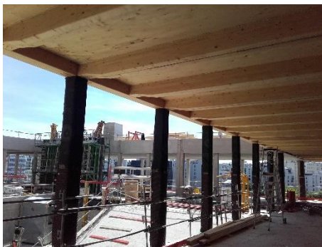
photographie Bouygues Immobilier – Façade
