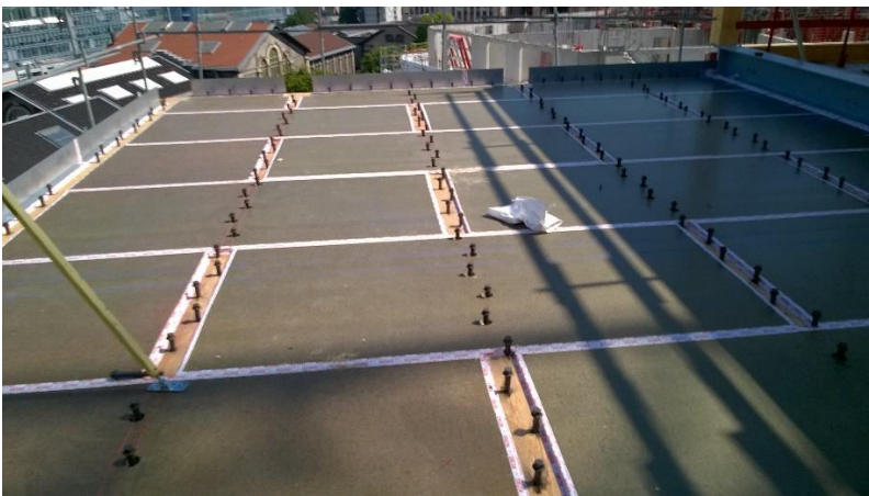
photographie Bouygues Immobilier – Plancher mixte en toiture
