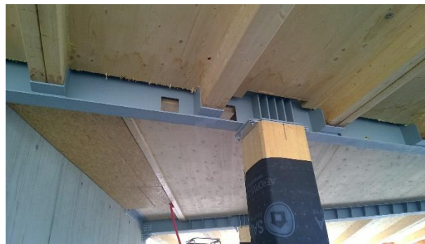
photographie Bouygues Immobilier – Porteur intérieur
