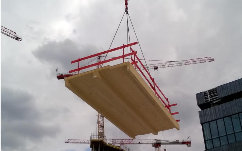
photographie Bouygues Immobilier – Plancher de 1 er jour
